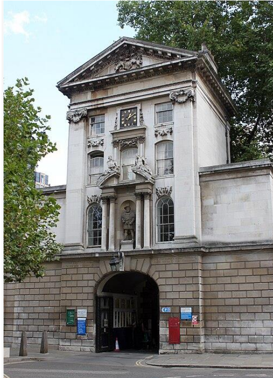
Figura 1.- Fachada del The Royal Hospital of Saint Bartholomew. Londres.
